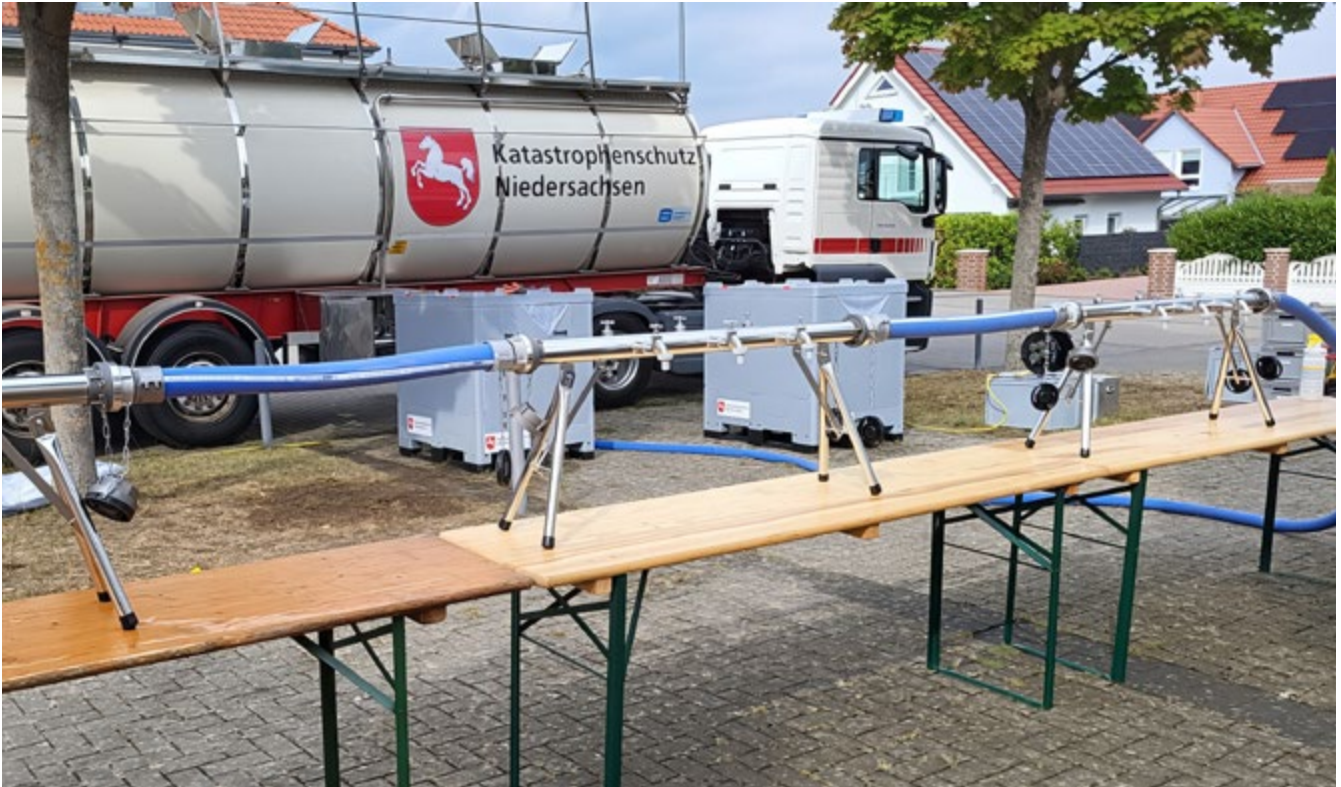
Trinkwasserentnahmestelle in Ochtersum
